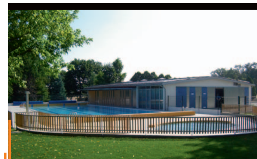
• Réhabilitation de la piscine d'Herbault en 2009
