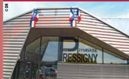
► La construction du nouveau gymnase a nécessité dix mois de travaux.
