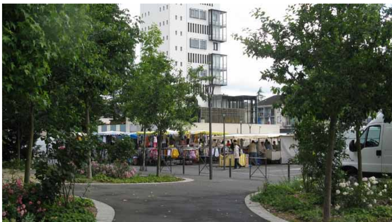
Quartier Europe à Tours - aménagement de la place du Nord Création de la mairie de quartier et sept logements
