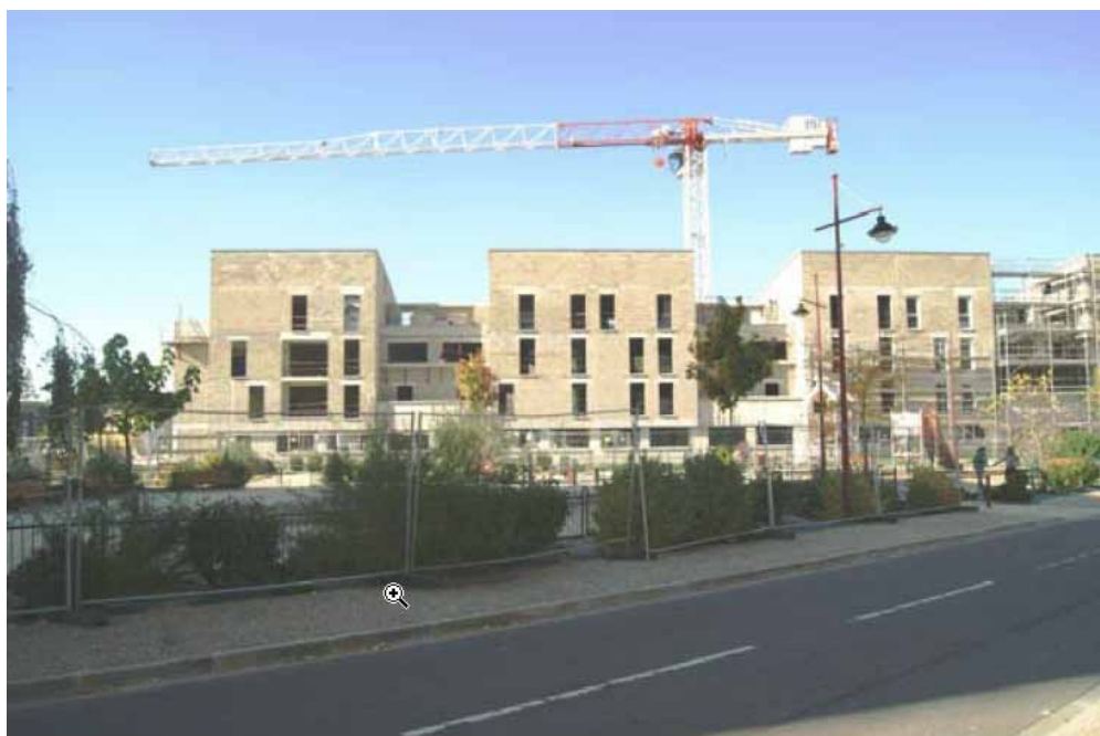
Les vauvettes à Vernouillet - Vue de la rue Hector Berlioz - 12 octobre 2010 28 logements
