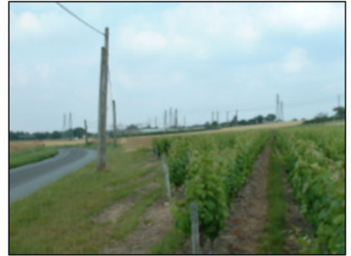
Concentration d'infrastructures électriques à proximité du poste électrique de Vendôme
