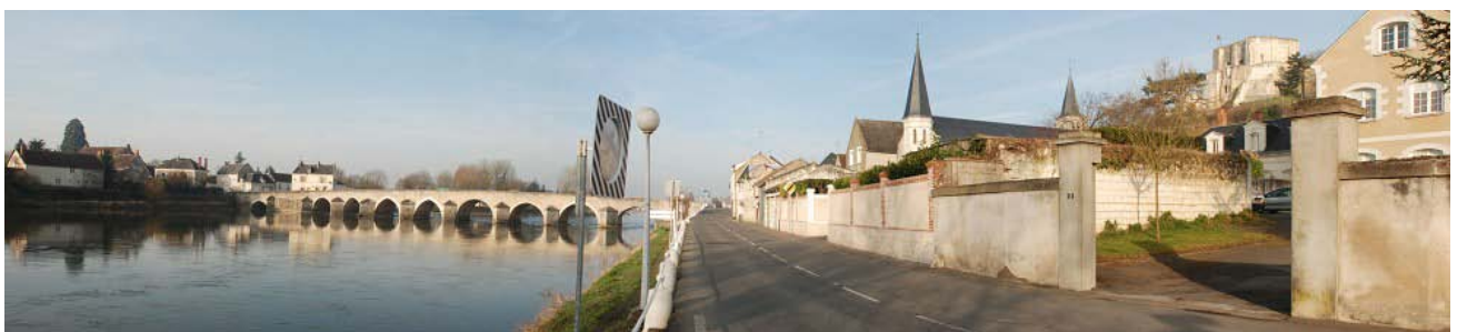
Pont de pierre de Montrichard, enjambant le Cher
