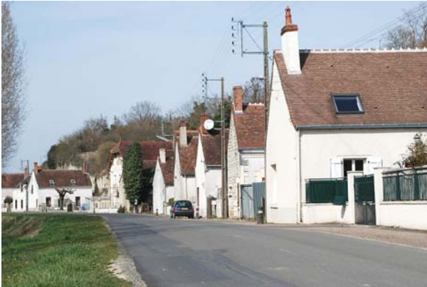
L'habitat troglodytique implique une forme urbaine « en peigne », c'est-à-dire perpendiculairement à la falaise exploitée pour l'extraction de la roche, Châteauneuf
