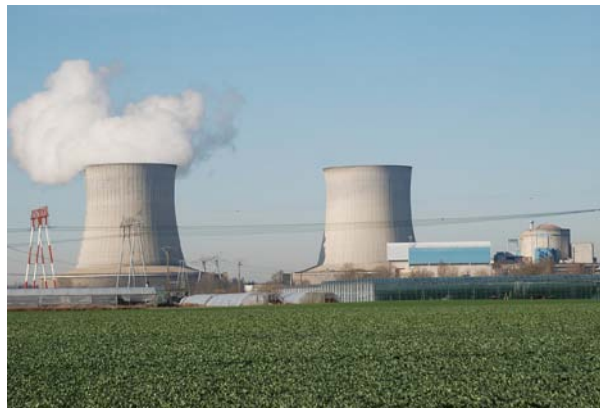
Serres de production florale dont le chauffage est en partie assuré par l'eau de la centrale nucléaire
