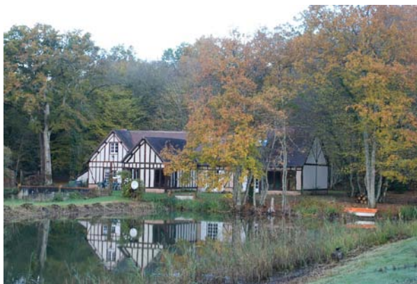
Ancien corps de ferme en pans de bois et torchis, Bonvau, la Ferté-Saint-Cyr
