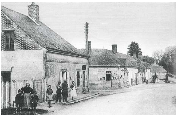
Dans cette rue d'Ambloy, au début du XXème siècle, les toits sont rehaussés de chiens assis et de cheminées en briques et les murs de chaînages de tuffeau
