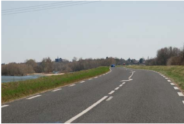
Route en levée offrant une large perception de la vallée de la Loire, RD951 à Montlivault
