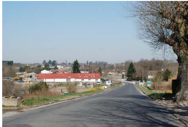
Problème de construction de bâtiment d'activités en plaine, au pied de Montlivault
