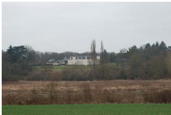
Château de Rocon, installé sur le rebord du coteau, Coulange
