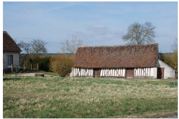
Grange à pans de bois et torchis, Fontaines-en-Sologne
