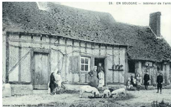
Ferme traditionnelle dont les pans de bois sont complétés par la « chantignolle » disposée en « feuille de fougère », carte postale
