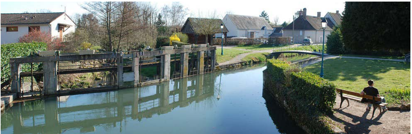
Centre de Monteaux, aménagé autour de l'écluse de la Petite Cisse
