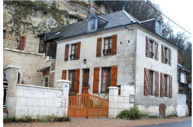
Maisons construites en tuffeau dans le prolongement des salles d'excavation, Les Roches-l'Évêque
