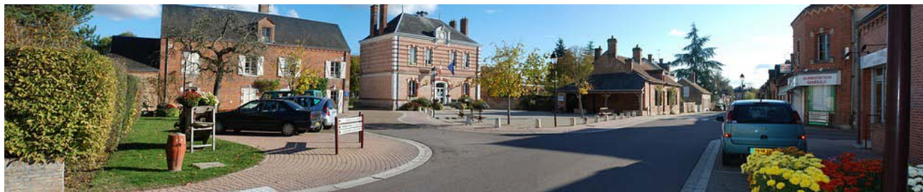
Centre bourg de Vouzon, entièrement construit de briques
