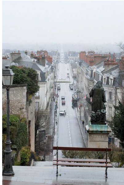
Escalier monumental Denis Papin, qui dévale le coteau de la Loire
