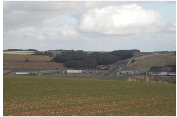
la déviation de la RN 157 et des bâtiments d'activités implantés sur le fragile coteau de Morée
