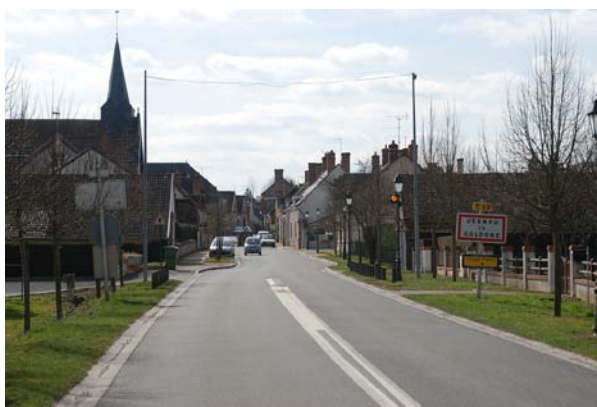
Aménagement de bords de chaussées enherbés, valorisant l'ambiance champêtre de l'entrée de village, Vernou-en-Sologne
