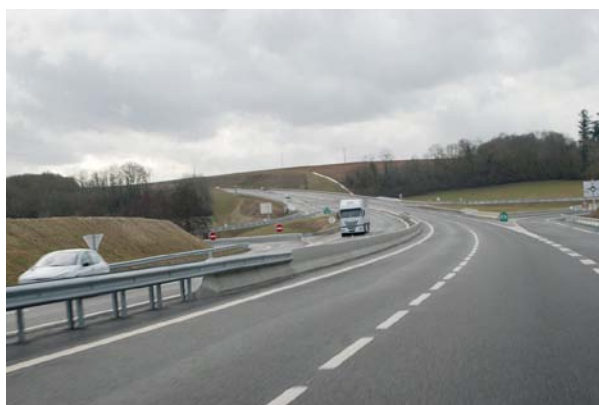
La N10, large infrastructure routière, à Pezou
