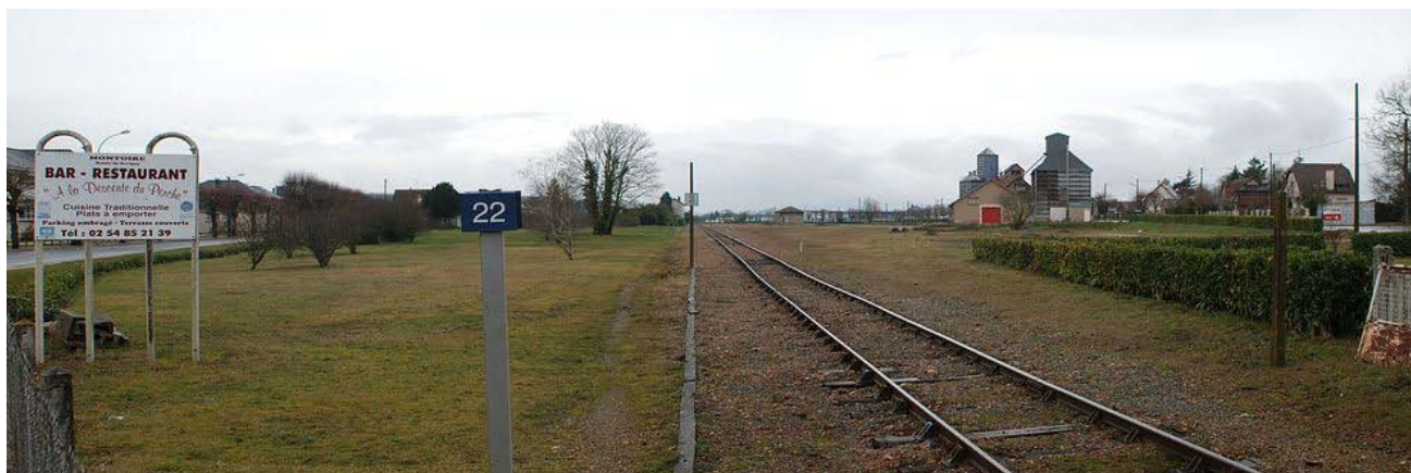
Espaces vacants aux abords de la gare de Montoire-sur-le-Loir
