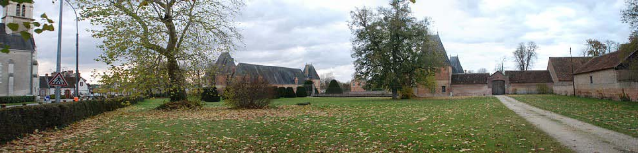
Château de La Ferté-Imbault, dont la reconstruction en brique date du XVIIe siècle
