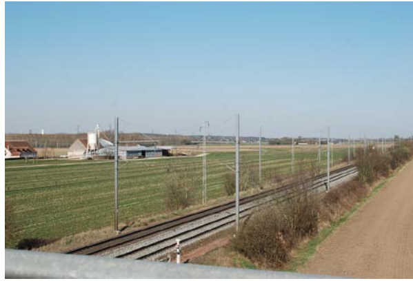
Voie ferrée Orléans/Tours traversant la plaine agricole de la Loire
