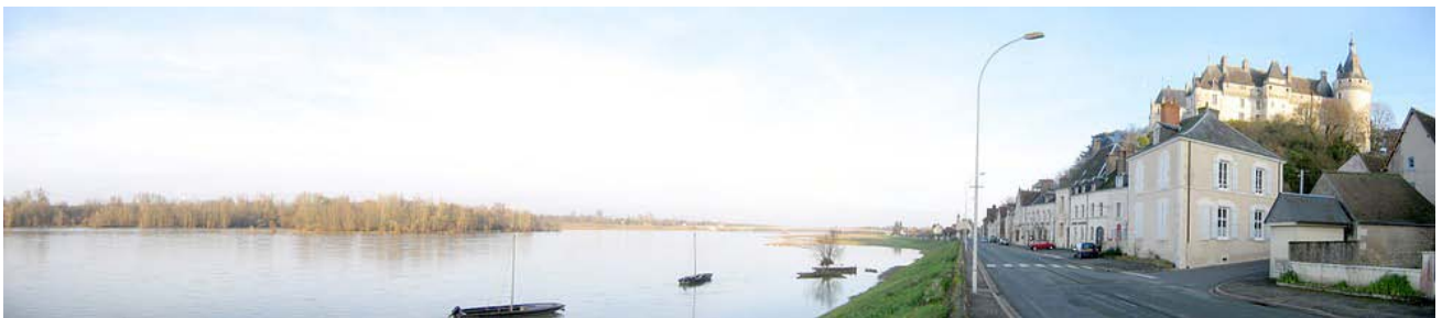
Chaumont-sur-Loire, installé sur la levée contre la falaise en rive gauche
