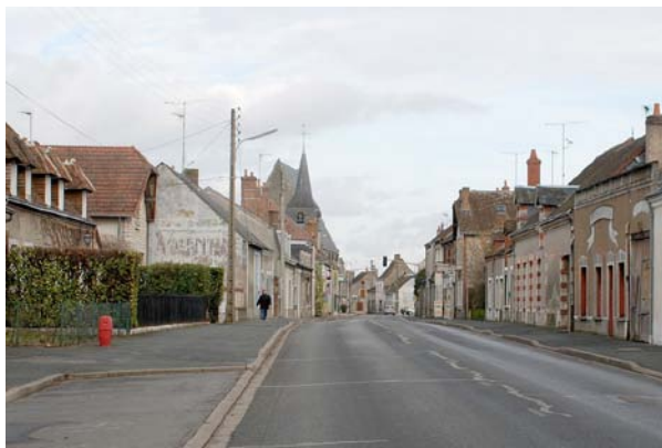
Centre de Pezou, marqué par une diversité de matériaux rappelant le Perche Vendômois
