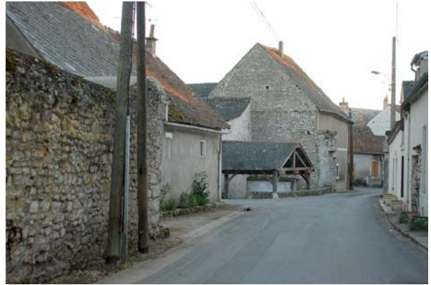
Constructions en calcaire de Beauce – Suèvres
