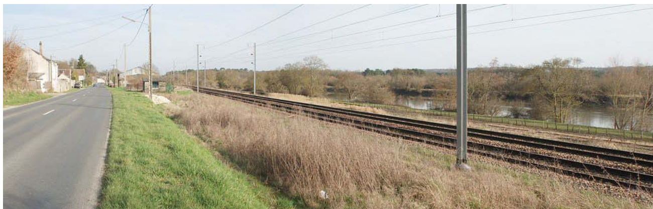
Pied de coteau étroit occupé par la RD 176, la voie ferrée et bordé par le Cher, Vineuil, Monthou-sur-cher
