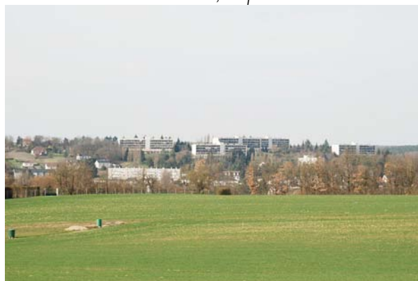
Grands ensembles construits en sommet de coteau, Montrichard
