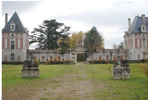
Dernières traces de la brique, présente dans la construction du château de Selles-sur-Cher
