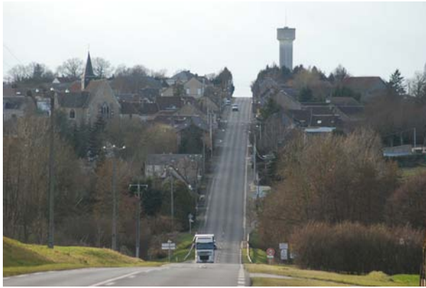
Traversée de village constituant une fracture dans le tissu urbain qui subit le trafic routier
