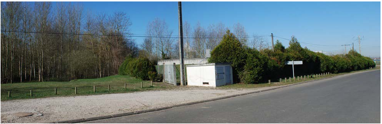
Clôture et abords de locaux techniques constituant un point noir dans le paysage
