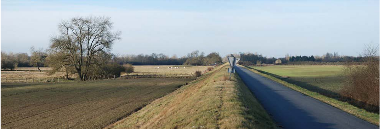
Levée de la Loire séparant les terres humides occupées par les pâtures des terres asséchées cultivées, les Prêles, Mer
