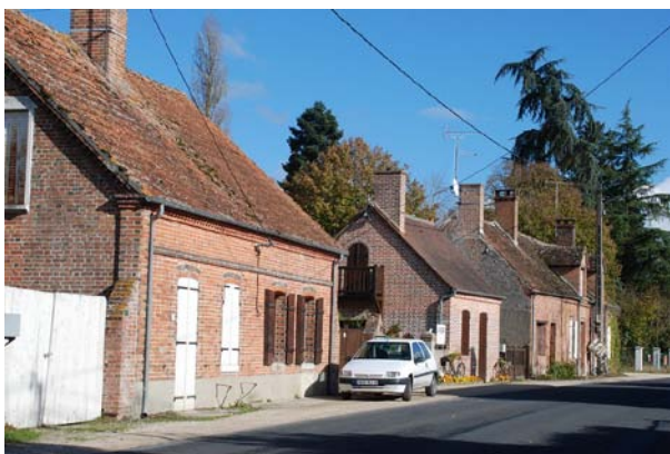
Tuiles et briques, associées parfois à un enduit, la Ferté-Beauharnais
