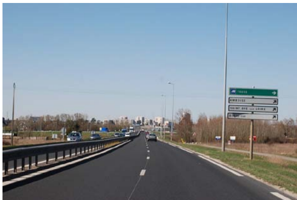
Entrée sud de Blois, par le pont Charles-de-Gaulle, à l'aspect très routier
