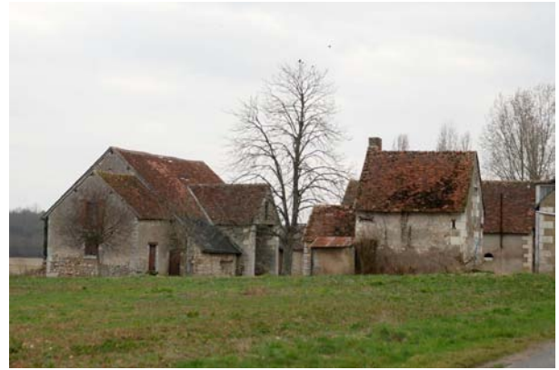
Ferme isolée constituée d'une juxtaposition de petits bâtiments en calcaire et tuiles plates, agrémentée par la présence de quelques arbres à grand développement, la Pieuse, Valaire
