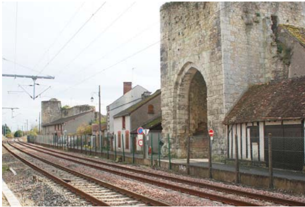
Rupture forte inscrite dans l'urbanisation de Mennetou-sur-Cher, liée à l'implantation de la voie ferrée.
