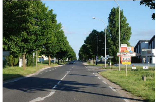
Entrée de Blois plantée
