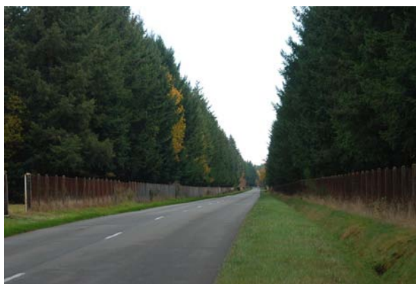
Route forestière bordée de peuplements de résineux au sombre couvert, entre Saint-Viâtre et Nouan-le-Fuzelier
