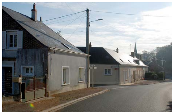
En 2009, l'architecture s'est largement simplifiée par la suppression des cheminées mais surtout par la disparition des chiens assis et leur remplacement par des velux : la complexité du volume bâti est gommée ce qui lui donne un aspect plus
