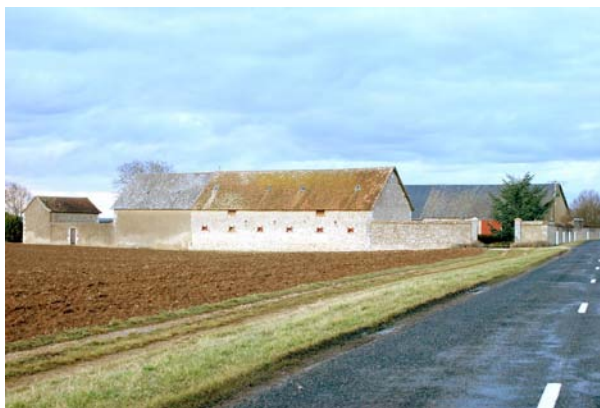
Ferme à cour carrée, construite en calcaire de Beauce, Bardy,
