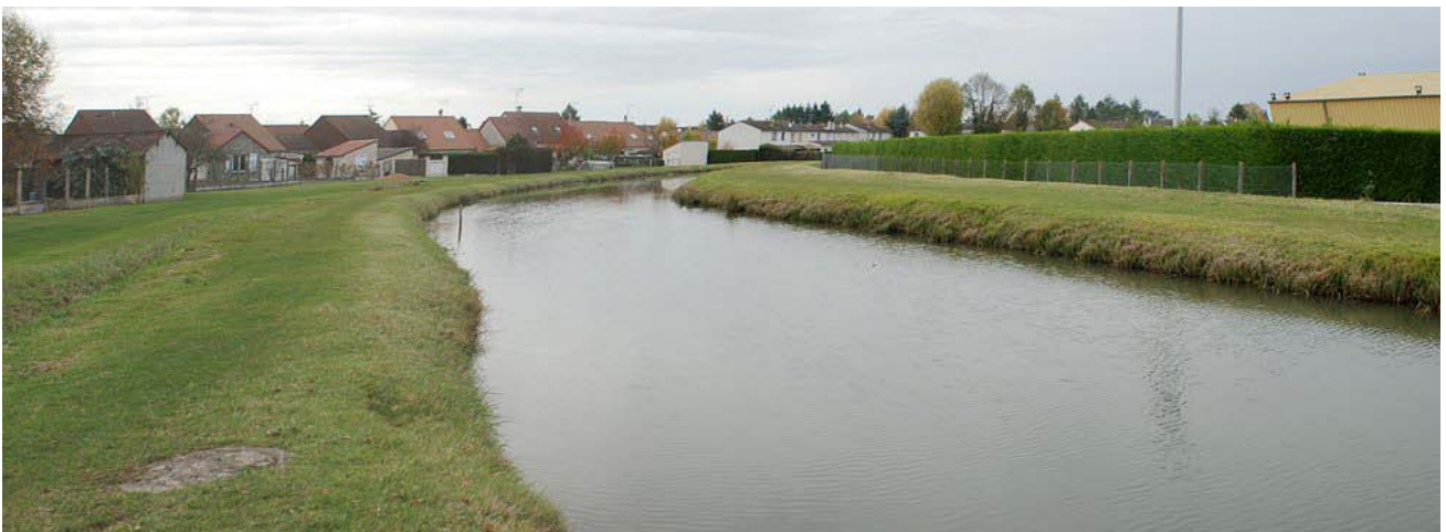
Problème d'urbanisation individuelle auprès du Canal de Berry, sans traitement des limites urbaines ou des espaces publics, ouest de Selles-sur-Cher
