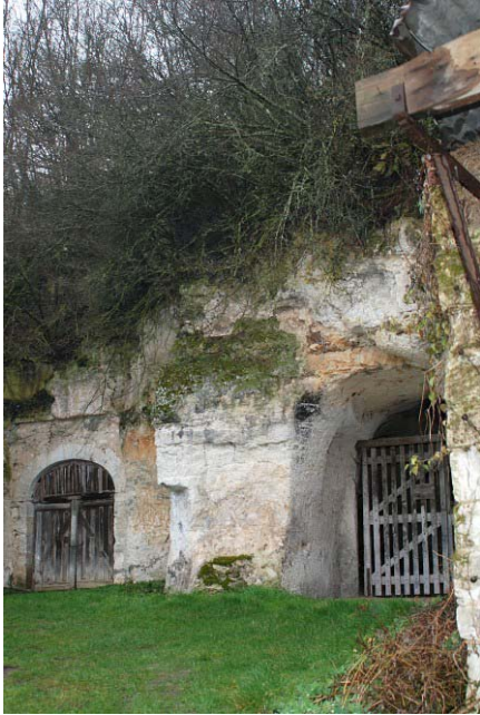
Caves troglodytiques creusées dans le tuffeau tendre
