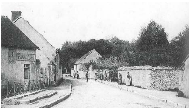
En 1910, la traversée de Saint-Bohaire est accompagnée de beaux murs de pierre qui viennent enclore des jardins
