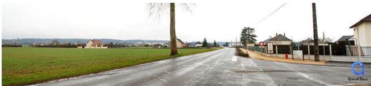
Entrée de ville de Montoire-sur-le-Loir, peu valorisée
