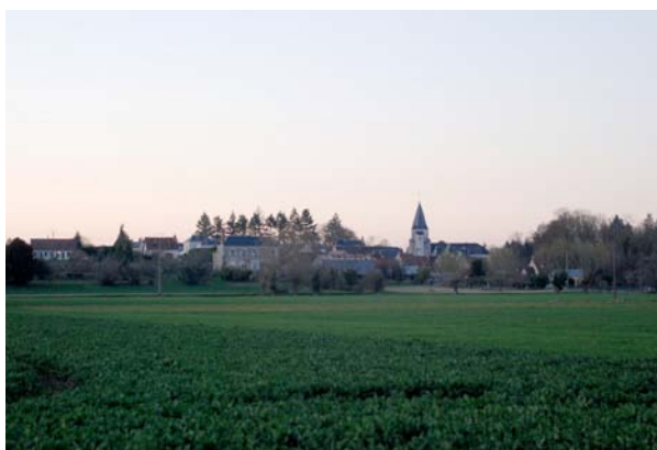
Village d'Avaray, implanté en pied de coteau sur la rive droite de la Loire
