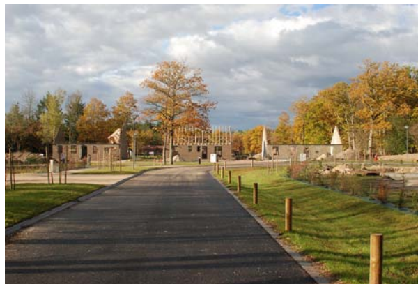
Nouveau lotissement en construction, sortie nord de la Ferté-Saint-Cyr
