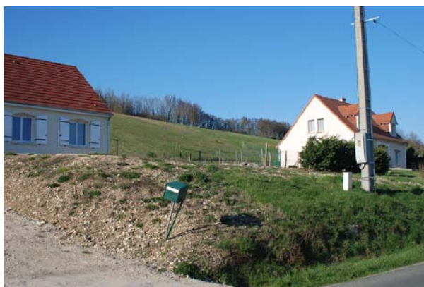
Construction récente en extension d'Asnières, Onzain
