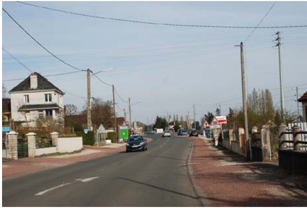
La RD 176, à laquelle s'agglutine l'urbanisation linéaire, sortie ouest de Montrichard
