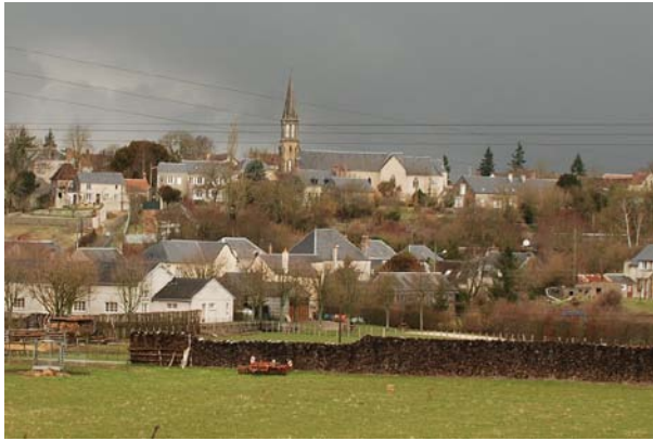
Bâti calcaire coiffé d'ardoise dans la vallée du Gondré, Houssay
