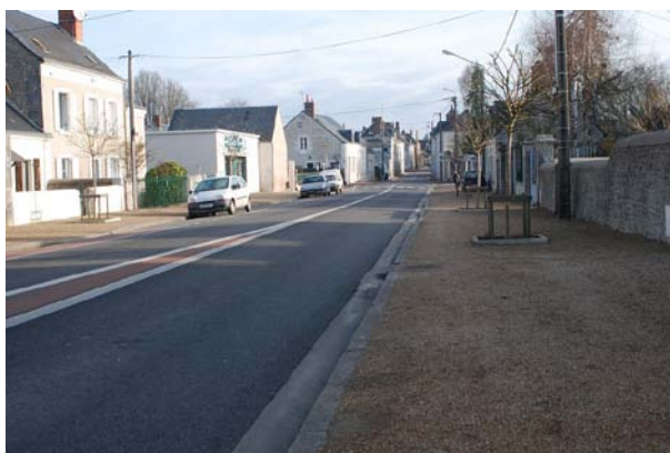
Entrée de Pontlevoy, réaménagée récemment
