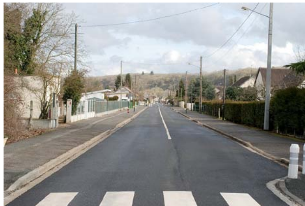
Traversée de Fréteval par la RN 157, nécessitant une requalification
