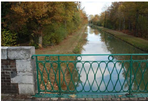
Canal de Blancafort – vue vers l'ouest – Pierrefitte-sur-Sauldre
