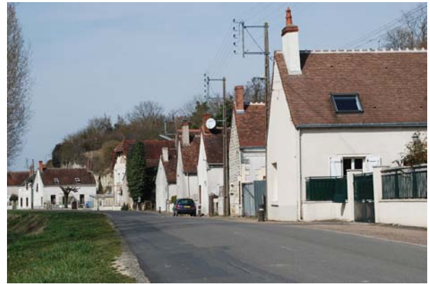
Quartier troglodytique de Madelon, installé au pied de la falaise, Châteaueux
