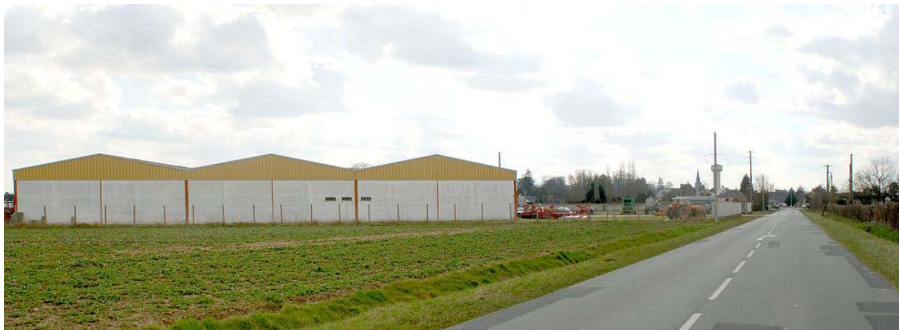
Bâtiment d'activités manquant d'une enveloppe végétale et dévalorisant l'entrée de village
