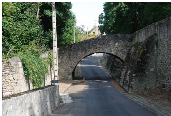
Pont reliant des jardins par-dessus une ruelle, Montlivault
