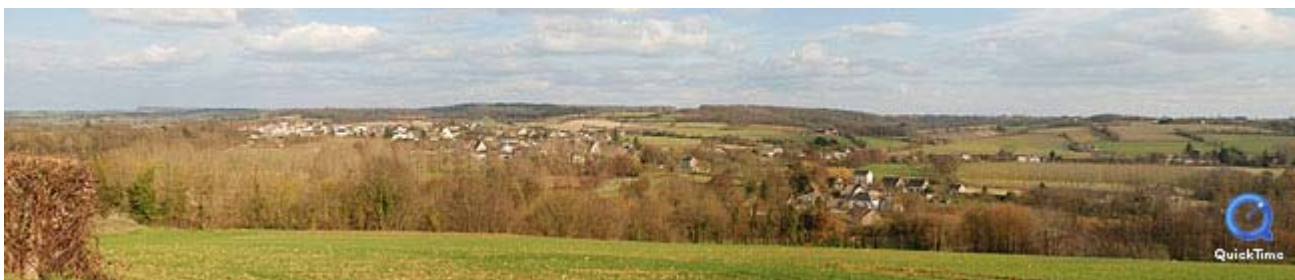
Diffusion de l'urbanisation de façon désordonnée, en piémont, sur les flancs ou en sommet de coteaux, Sargé-sur-Braye
