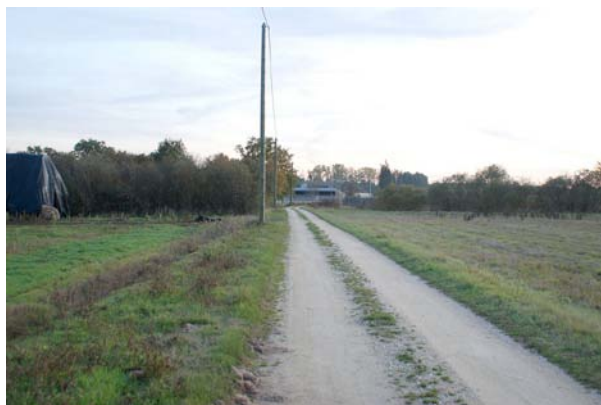
Exemple de voie de desserte en stabilisé nécessitent une gestion raisonnée et peu coûteuse adaptée à une faible fréquentation
