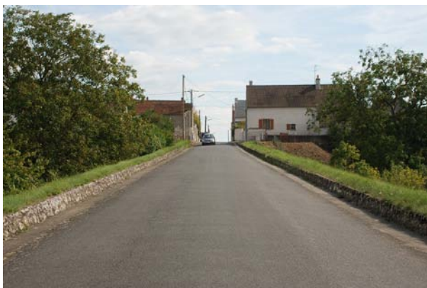
Route de Blois construite en rampe perpendiculaire au coteau, Montlivault
