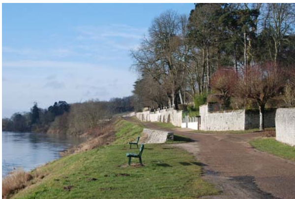
Murs d'enceinte des jardins de rive et promenade de bord de Loire, Cour-sur-Loire
