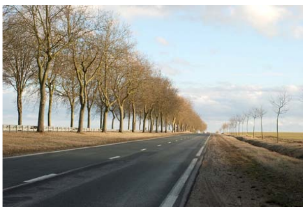
La RD 957 réaménagée entre Vendôme et Villeromain
