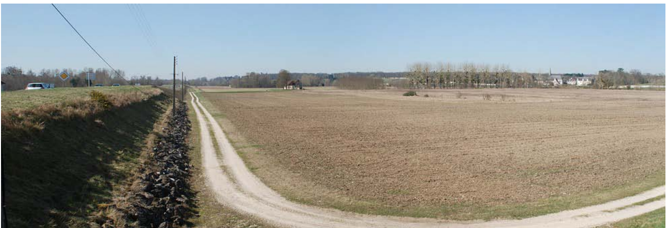
Section de levée peu valorisée, RD95 I, Montlivault
