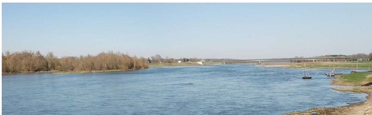
Pont de Chaumont-sur-Loire, unique point de traversée de la Loire
