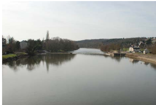
Pertuis du barrage du Port, à Saint-Georges-sur-Cher
