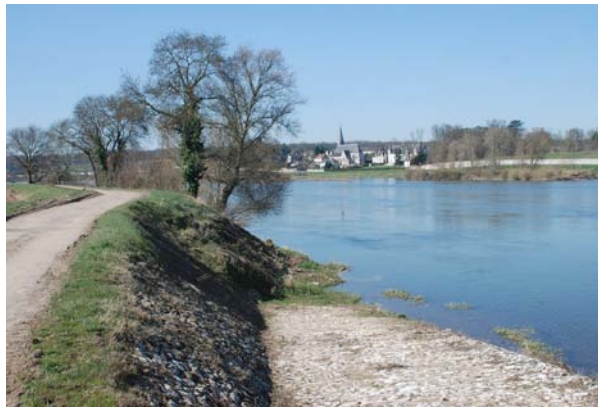
Levée à Montlivault, face à Cours-sur-Loire
