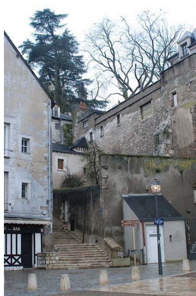
Escaliers de la place Etienne Gaudet, adossés aux remparts du Château
