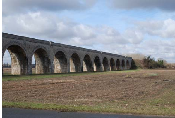
L'ancienne voie ferrée qui reliait Vendôme à Romorantin, aujourd'hui abandonnée, Vineuil
