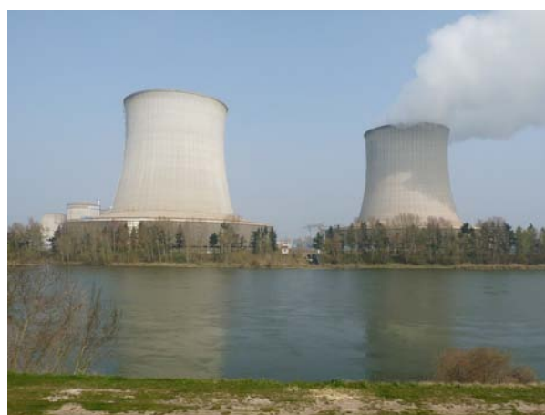
La centrale, objet monumental posé sur la plaine de Loire
