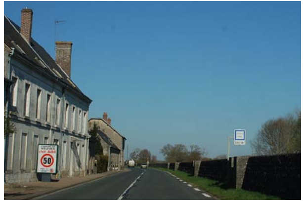
Traversée de Veuves par la RN 152, rehaussée par une levée et un muret maçonné
