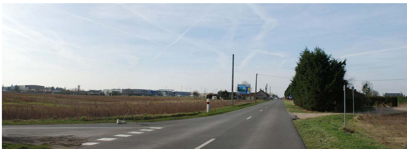
Entrée de ville de Contres banalisée par sa zone d'activités
