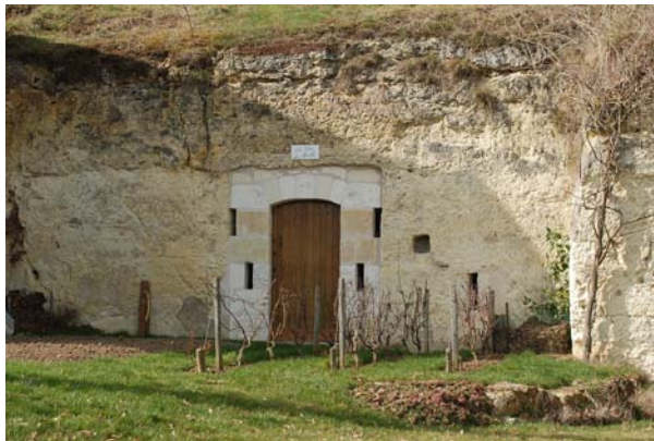
Cave troglodytique restaurée en tuffeau en 2005 et habillée par trois rangs de vigne, Châteaueux
