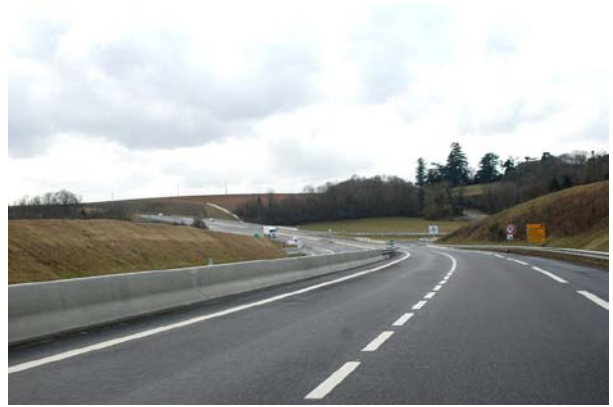
La RN10, massive infrastructure routière déconnectée du paysage qui l'entoure
