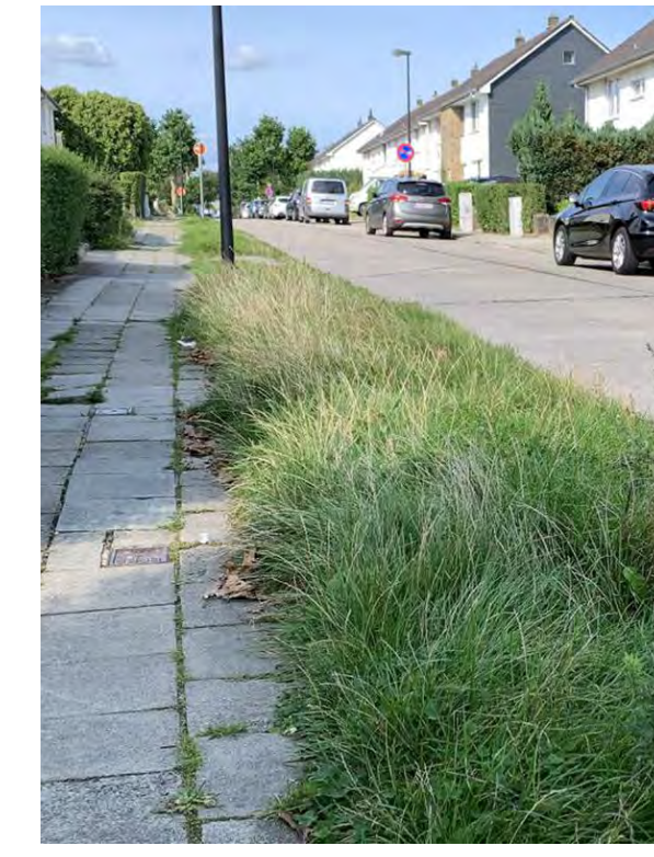
Bande enherbée séparant la voirie de l'espace piéton. Absorption des eaux de ruissellement de la chaussée.
