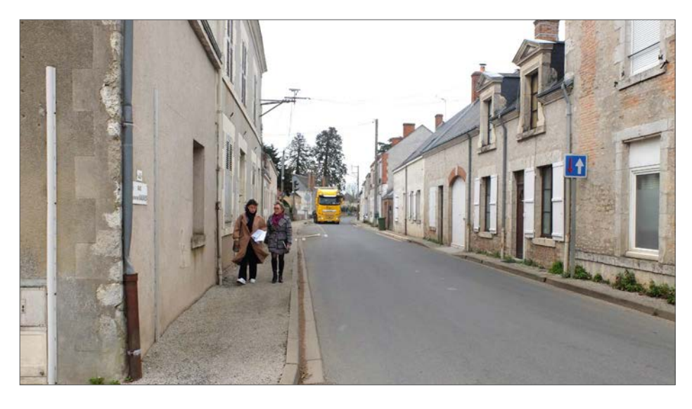
La route départementale D917 rue Alphonse Saunier : une rue étroite dans la partie bourg qui génère un sentiment d'insécurité pour le piéton au contact d'une circulation importante
