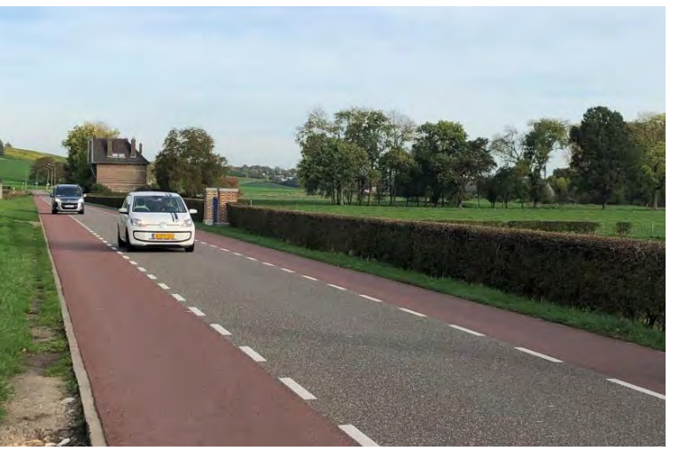
Chaussidou, un dispositif pour favoriser/sécuriser les déplacements cyclables en espace contraint
