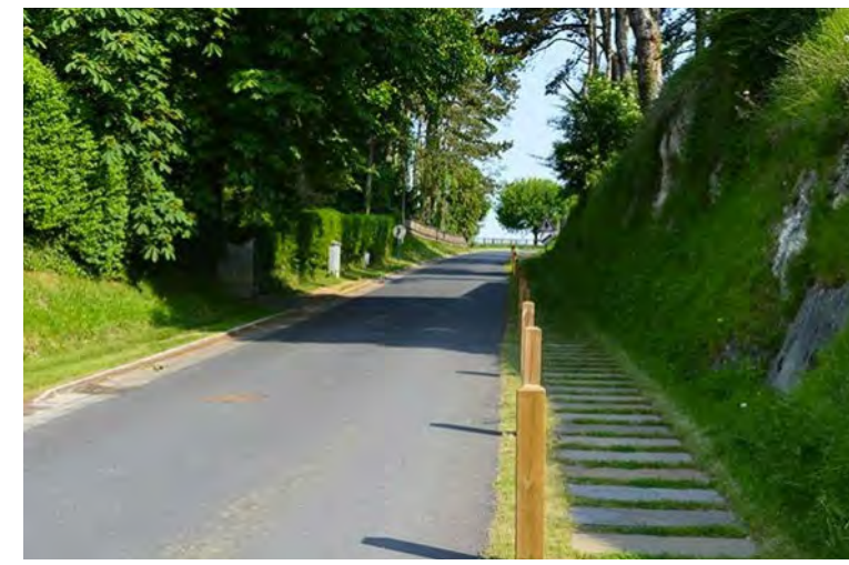
Aménagement d'une continuité piétonne, Gonnevilliers-sur-Mer (14)
