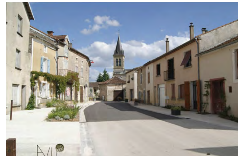
Sécurisation d'une traversée en centre-bourg avec aménagement d'espaces piétons
