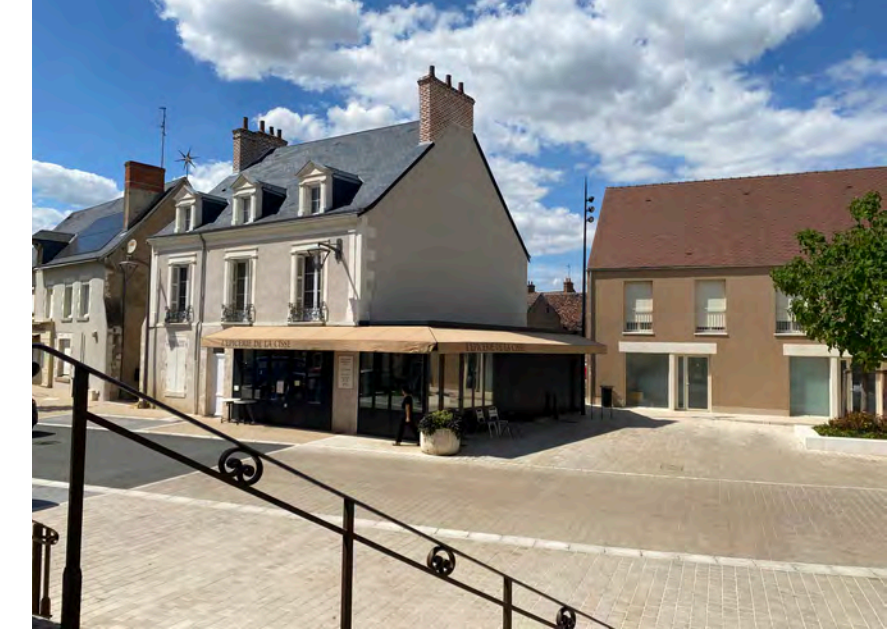
Traitement de l'espace public et des façades
