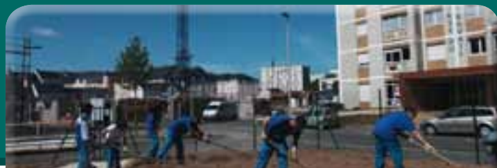
Chantier d'insertion sur les espaces délaissés, avant replantation.
